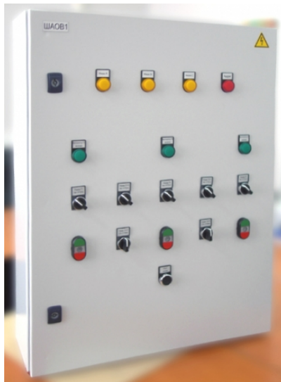
Пример шкафа автоматизации
