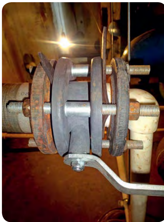
ПОДВАЛ ЖИЛОГО ДОМА (КОНТУР ГВС)
