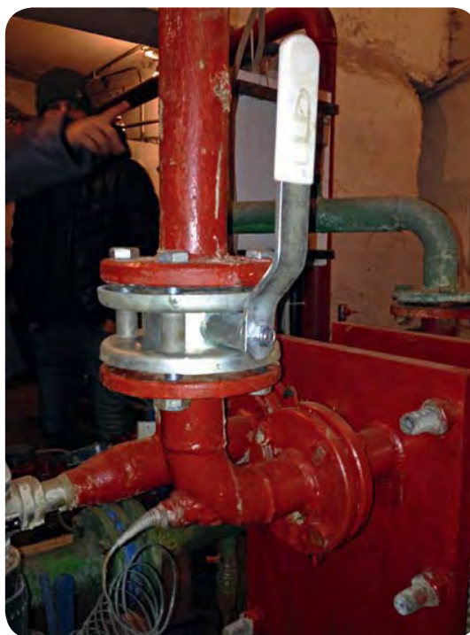
КОНТУР ГВС ПОСЛЕ ПЛАСТИНЧАТОГО ТЕПЛООБМЕННИКА
