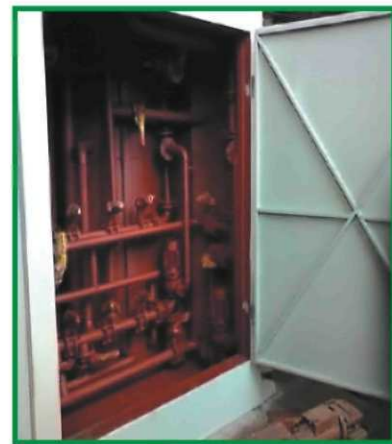
Компактное машинное отделение – встраивается под емкостями
