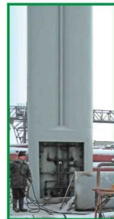
Компактное машинное отделение – встраивается под емкостями
