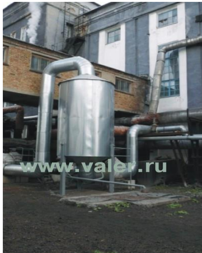
Фото 4. Инерционно-гравитационный грязевик ГИГ-2300 установлен в 2007 г. в ОАО "ТГК-9", Интинская ТЭЦ.
