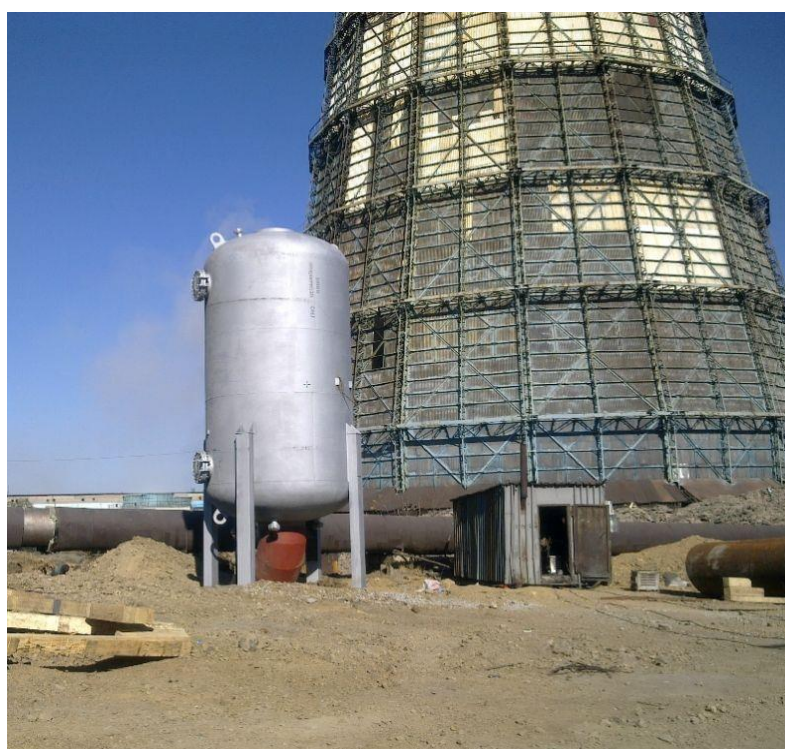
Фото 16. Монтаж грязевика ГИГ- 5200 на тепловых сетях Карагандинской ТЭЦ-3, Республика Казахстан.
