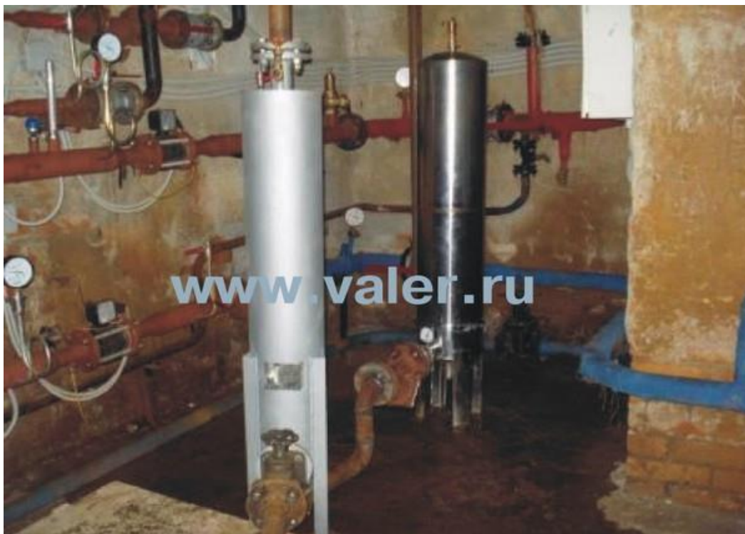
Фото 17. Грязевик ГИГ-15, установленный на вводе ГВС в жилой дом г. Пушкин, совместно с фильтром тонкой очистки горячей воды.
