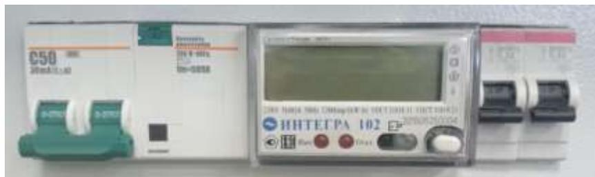
Счетчик ИНТЕГРА 102, установленный в этажном щитке
